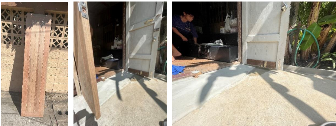
รื้อผนังเพื่อขยายประตูบ้าน ติดตั้งวงกบใหม่ จัดทำประตูเพิ่มเป็นประตูบานเปิดคู่ กว้างรวม ๑.๑๐ เมตร
