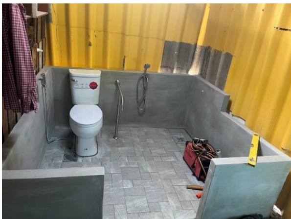
ติดตั้งโถสุขภัณฑ์ วาล์วเปิดปิดน้ำ ก๊อกน้ำ สายฉีดชำระ และฝักบัวอาบน้ำ ติดตั้งราวสแตนเลสช่วยพยุงตัวแบบยึดกับพื้น เนื่องจากผนังไม่แข็งแรง
