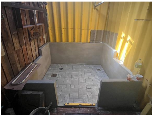
วางเหล็กตะแกรงและเทพื้นคอนกรีตทับหน้า ก่อผนังห้องน้ำความสูงประมาณ ๐.๘๐ เมตร ทดแทนส่วนล่างของผนังเดิมที่ชำรุด ปรับความลาดเอียงของพื้นเพื่อระบายน้ำ ปรับระดับพื้นห้องน้ำให้ต่อเนื่องกับระดับทางเข้าห้องน้ำ กระเบื้องพื้นห้องน้ำชนิดกันลื่น ติดตั้งฝาท่อระบายน้ำที่พื้น
