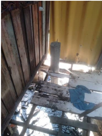
ตอกเสาเข็มและทำตอม่อ ค.ส.ล. ขุดหลุม วางบ่อเกรอะที่ตำแหน่งใหม่ วางคานเหล็กกับพื้นคอนกรีตสำเร็จรูป
