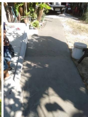
เทพื้นคอนกรีตเสริมเหล็กกว้าง ๑.๑๐ เมตร ความยาว ๘.๕๐ เมตรจากปลายทางลาดไปยังถนนคอนกรีตหน้าบ้าน
