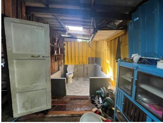
ซ่อมแซมโครงสร้างหลังคา มุงหลังคากระเบื้องลอนคู่ใหม่บางส่วน ซ่อมแซมผนังและหน้าต่างหลังบ้าน
