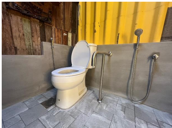
ติดตั้งโถสุขภัณฑ์ วาล์วเปิดปิดน้ำ ก๊อกน้ำ สายฉีดชำระ และฝักบัวอาบน้ำ ติดตั้งราวสแตนเลสช่วยพยุงตัวแบบยึดกับพื้น เนื่องจากผนังไม่แข็งแรง
