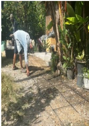
เทพื้นคอนกรีตเสริมเหล็กกว้าง ๑.๑๐ เมตร ความยาว ๘.๕๐ เมตรจากปลายทางลาดไปยังถนนคอนกรีตหน้าบ้าน
