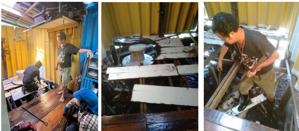
รื้อสุขภัณฑ์,อ่างอาบน้ำ และรื้อพื้นห้องน้ำเดิมออกทั้งหมด
