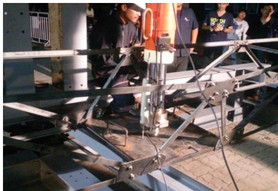
รูปที่ 2 แสดงการวางแผ่นเหล็กรับน้ำหนักบนคอร์ดล่าง
